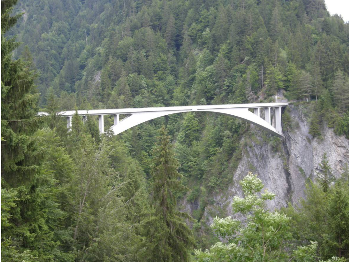
Abbildung 7: Salginatobelbrücke (erbaut 1929) bei Schiers von Robert Maillard
