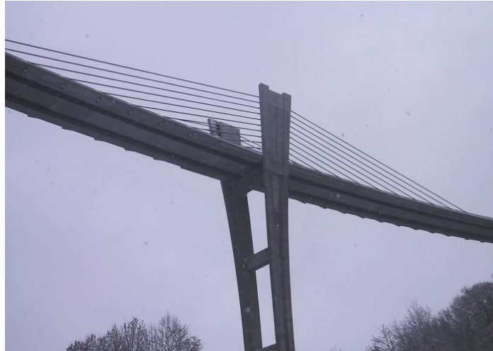
Abbildung 1: Sunnibergbrücke von Christian Menn bei Klosters – solch elegante Strukturen sind undenkbar ohne Beton (Eröffnung 2005)
